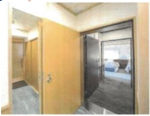
車いす移動が容易となるように引き戸を採用。扉幅や廊下幅も広めにとられています。
